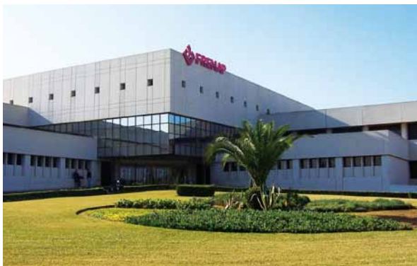
Hospital de Sevilla
